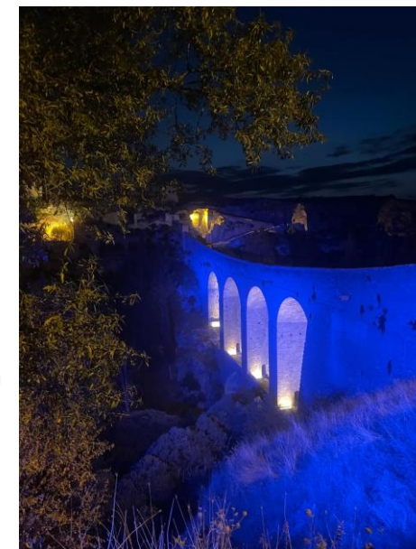
GRAVINA (PUGLIA) PONTE DELL'ACQUEDOTTO
